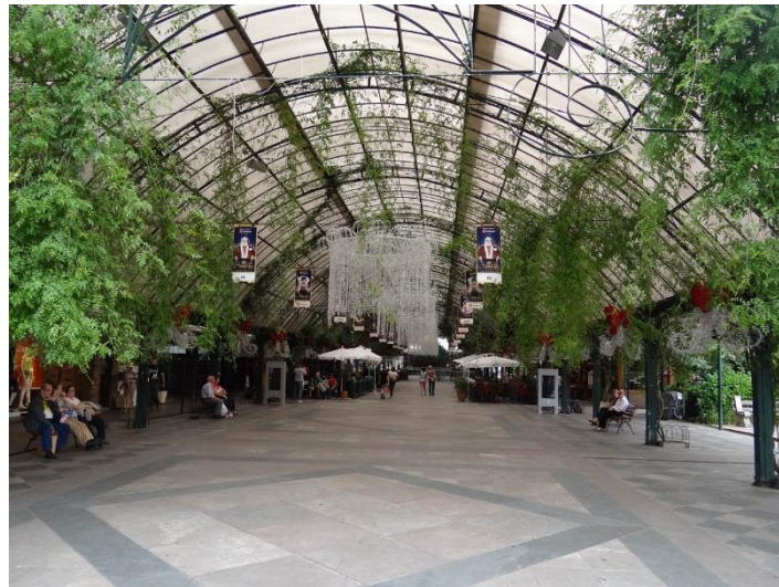
Figura 1: Rua Coberta de Gramado
