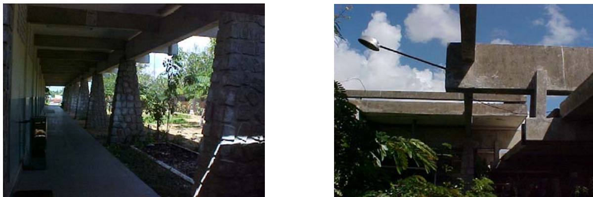
Setor de aulas: detalhes da estrutura.
