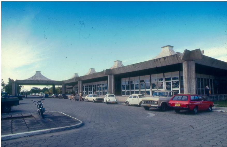
Figura 4: Vista da sede da SUFRAMA. Notar painéis leves modulares especificados para as áreas fechadas.
