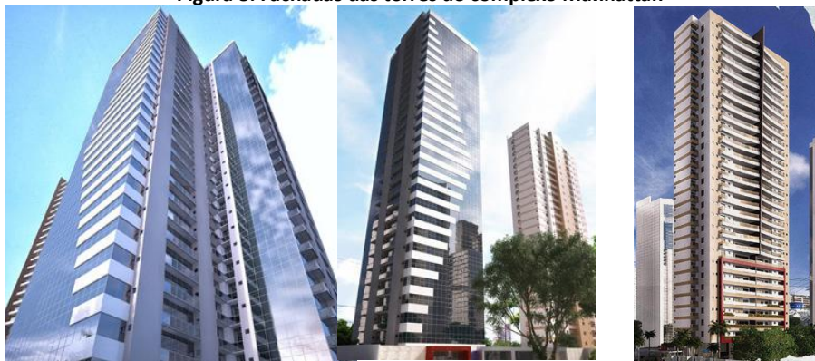
Figura 8: Fachadas das torres do complexo Manhattan
