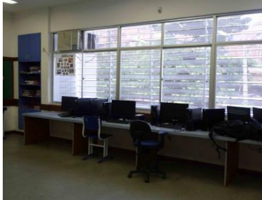
Figura 8 - Grandes aberturas com esquadria recuada e brises metálicos
