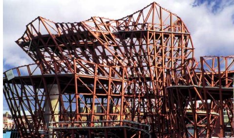
Figura 8: Estrutura metálica principal em montagem
