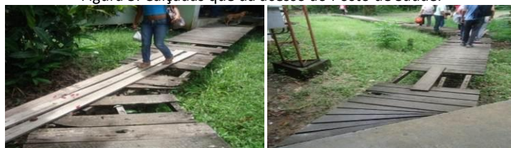
Figura 5. Calçadas que dá acesso ao Posto de Saúde.
