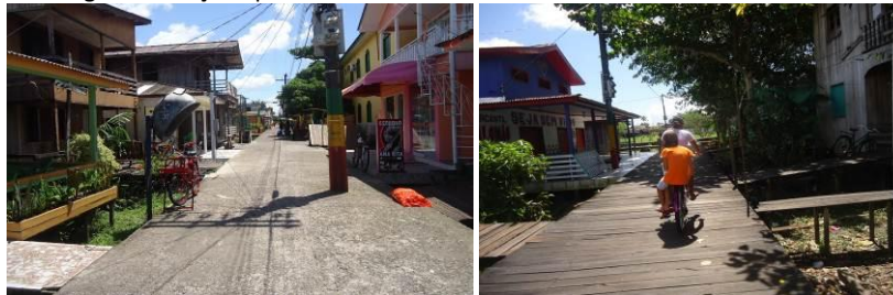
Figura 3- Calçada palafitada de concreto e de madeira da Cidade de Afuá
