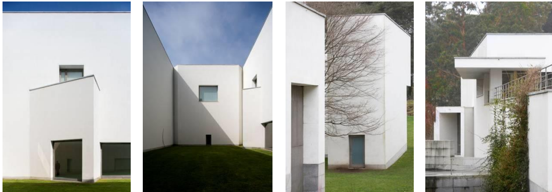
Figura 26 – Alguns detalhes externos do edifício.
