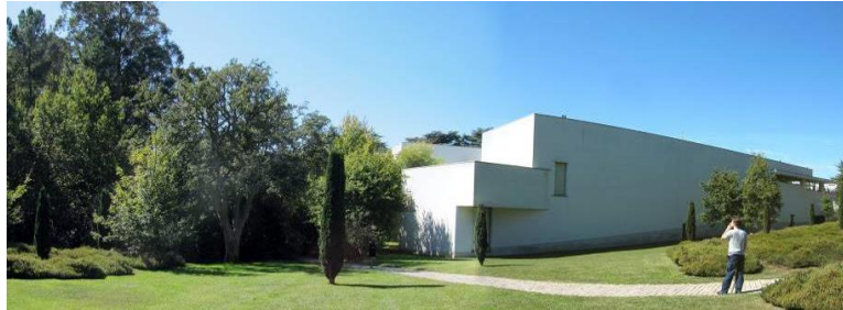
Figura 27 - Vista das faces voltadas para a porção mais interna do terreno.
