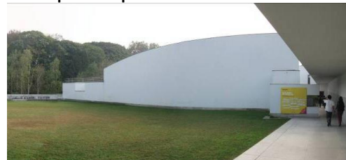
Figura 12 – Volume do auditório que delimita um primeiro pátio e antecede a entrada.
