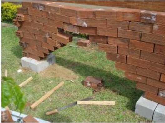
Figura 3: Pórticos de avanços sucessivos
