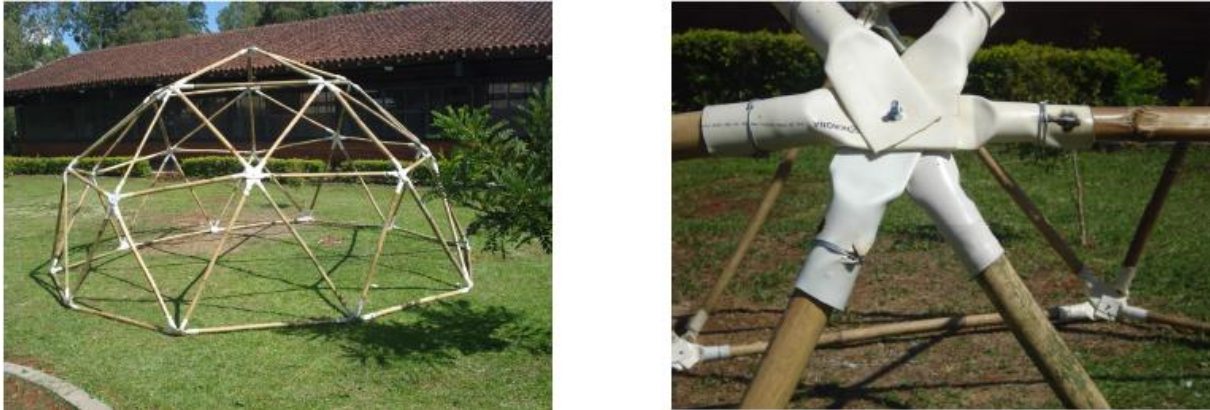
Figura 7: Cúpula treliçada e detalhe dos nós
