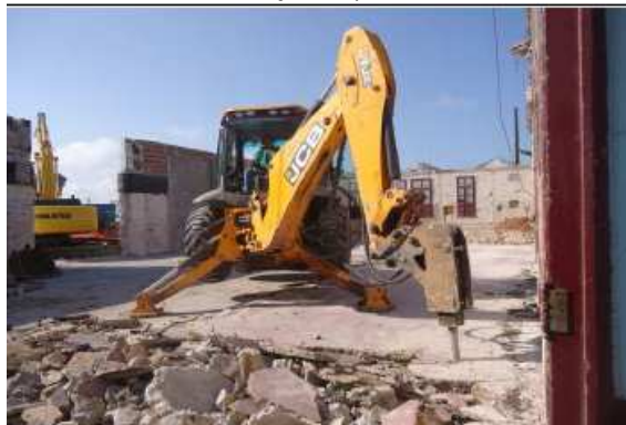
Figura 6: Demolição de paredes/piso para reforço na fundação do prédio.
