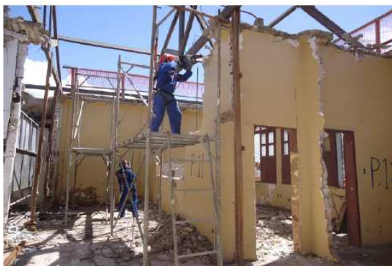
Figura 5: Retirada da cobertura para demolição da laje de concreto.
