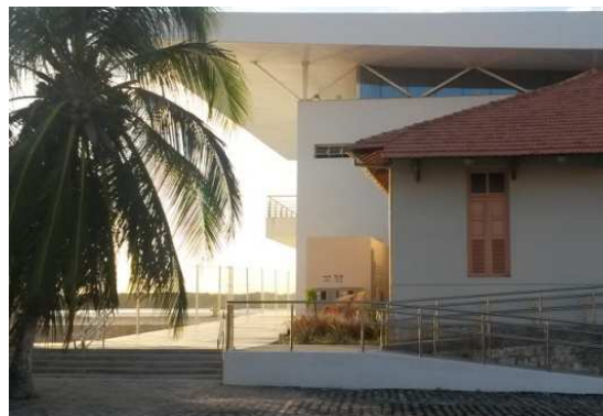
Figura 10: Vista do Largo da Rua Chile para o acesso lateral ao restaurante do primeiro andar.
