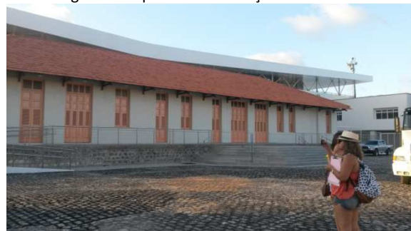
Figura 4: Depois da intervenção no edifício.
