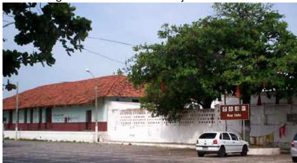
Figura 3: Antes da intervenção no edifício.
